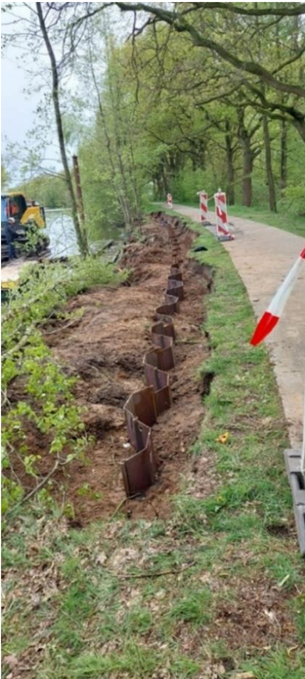
Figuur 3 Geplaatste damwand na het vinden van een beverhol in de kade
