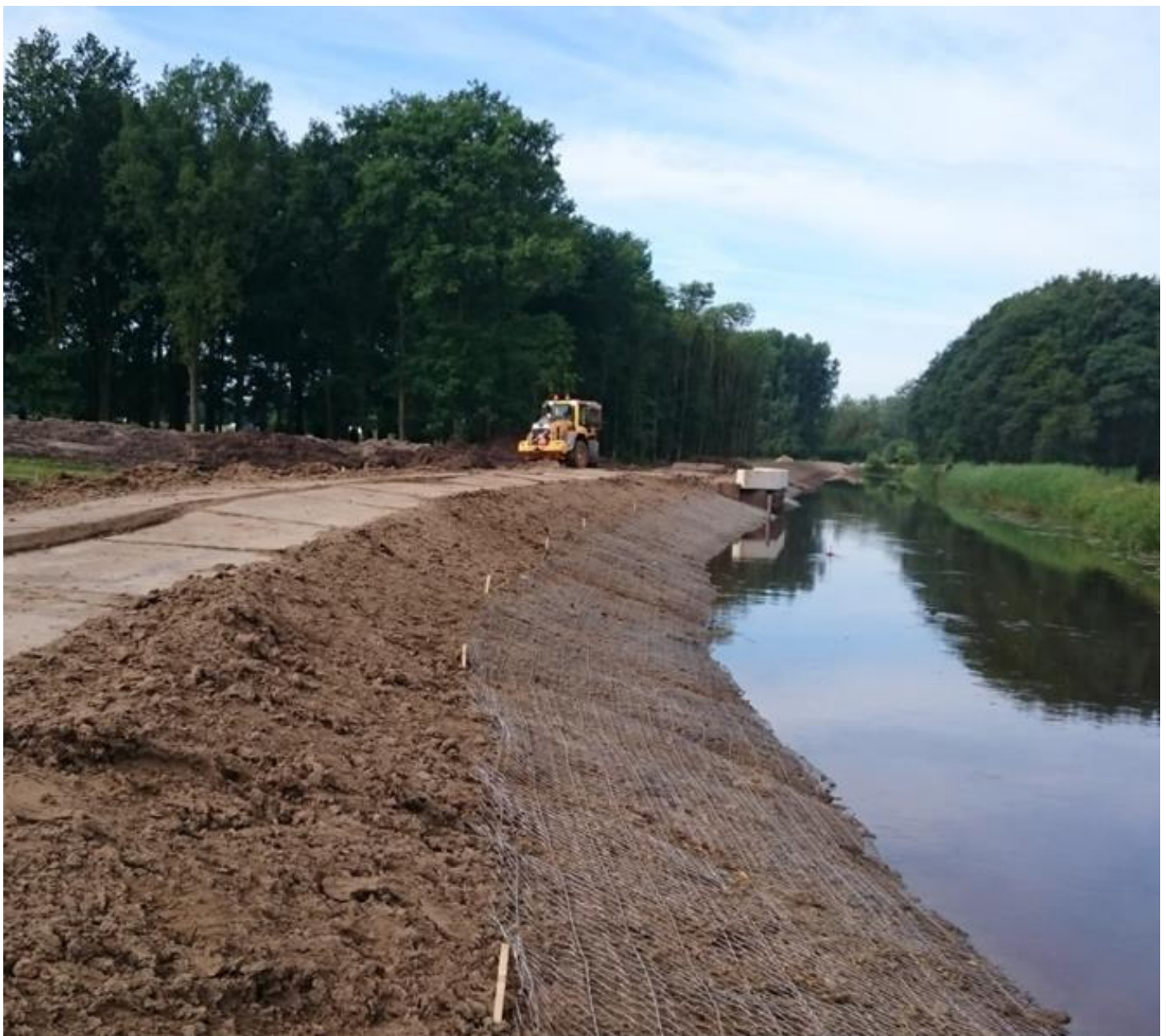
Figuur 12 Gaas aangebracht op het taluds van de Dommel. Op het gaas wordt nog een afdeklaag aangebracht. © Waterschap De Dommel
